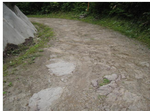
12.未舗装路区間 (約2.5km) 下り勾配の岩盤路面です。 スリップに注意! ピッチを小さく。
